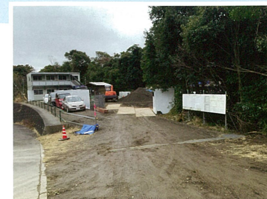
1月に建ち上がった建設事務所
